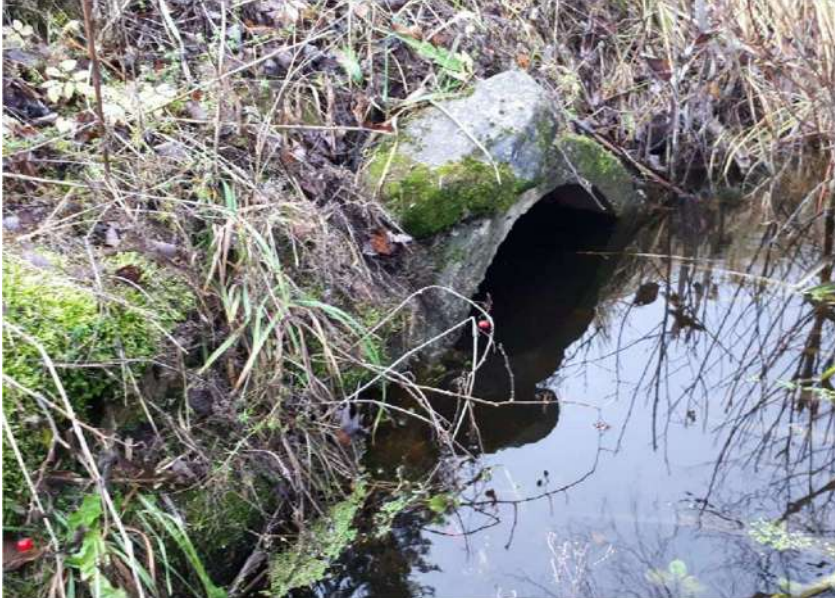
Foto 4. Vaade truubi T3 sissevoolule (08.11.2023). Truup heas seisundis. Osaline kivikindlustus otsakutel. Kraavi nõlvadel ja põhjas betoonplaatidest kindlustis.
